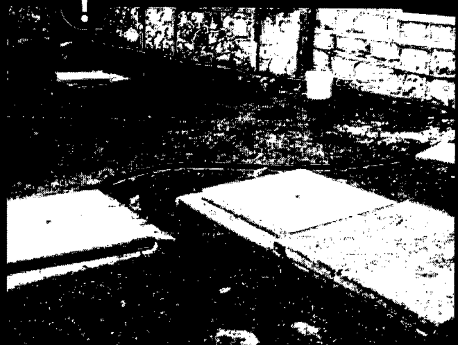
4. Vasche di captazione non protette
