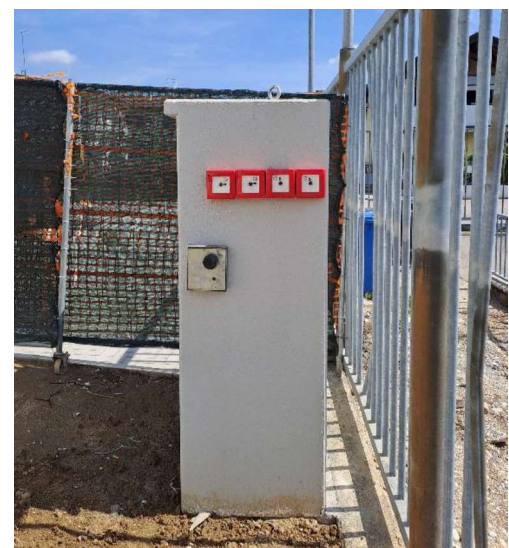
Foto 1 e 2 – interruttori di emergenza impianti elettrici
