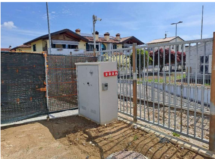
Foto 1 e 2 – interruttori di emergenza impianti elettrici
