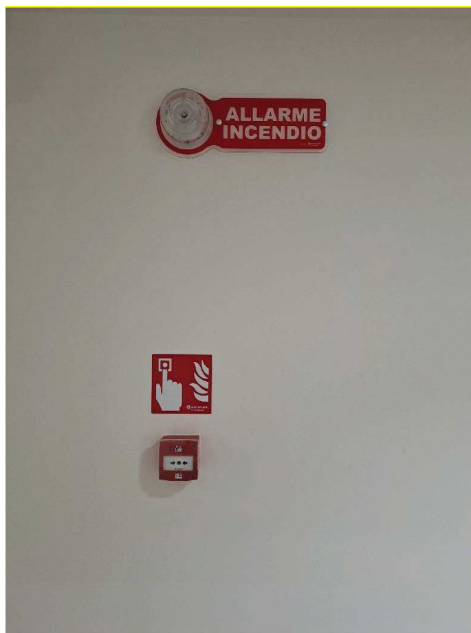
Pulsante manuale allarme incendio e targa ottico-acustica
