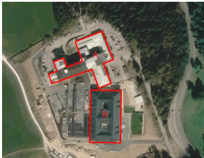
Vista aerea complesso ospedaliero Asiago – via Martiri Granezza n.42
