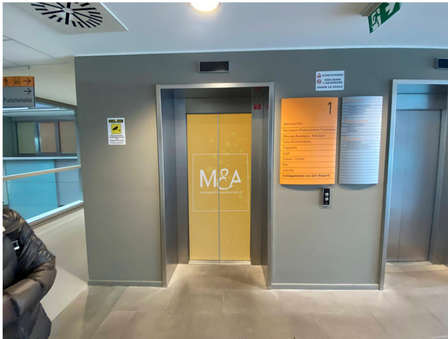
Pellicola adesiva porta ascensore piano terra
