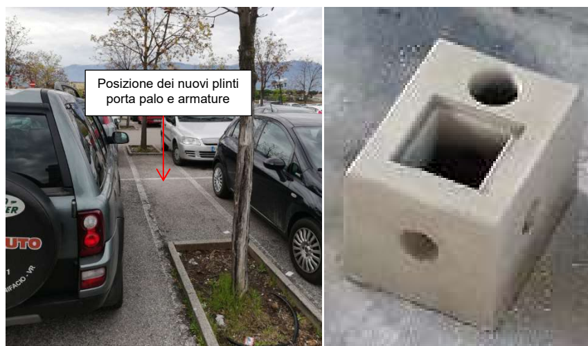
FOTO 5 - Particolare della posizione dei nuovi plinti porta palo e delle nuove armature a cavallo delle aiuole e tipico plinto porta palo in cls.
