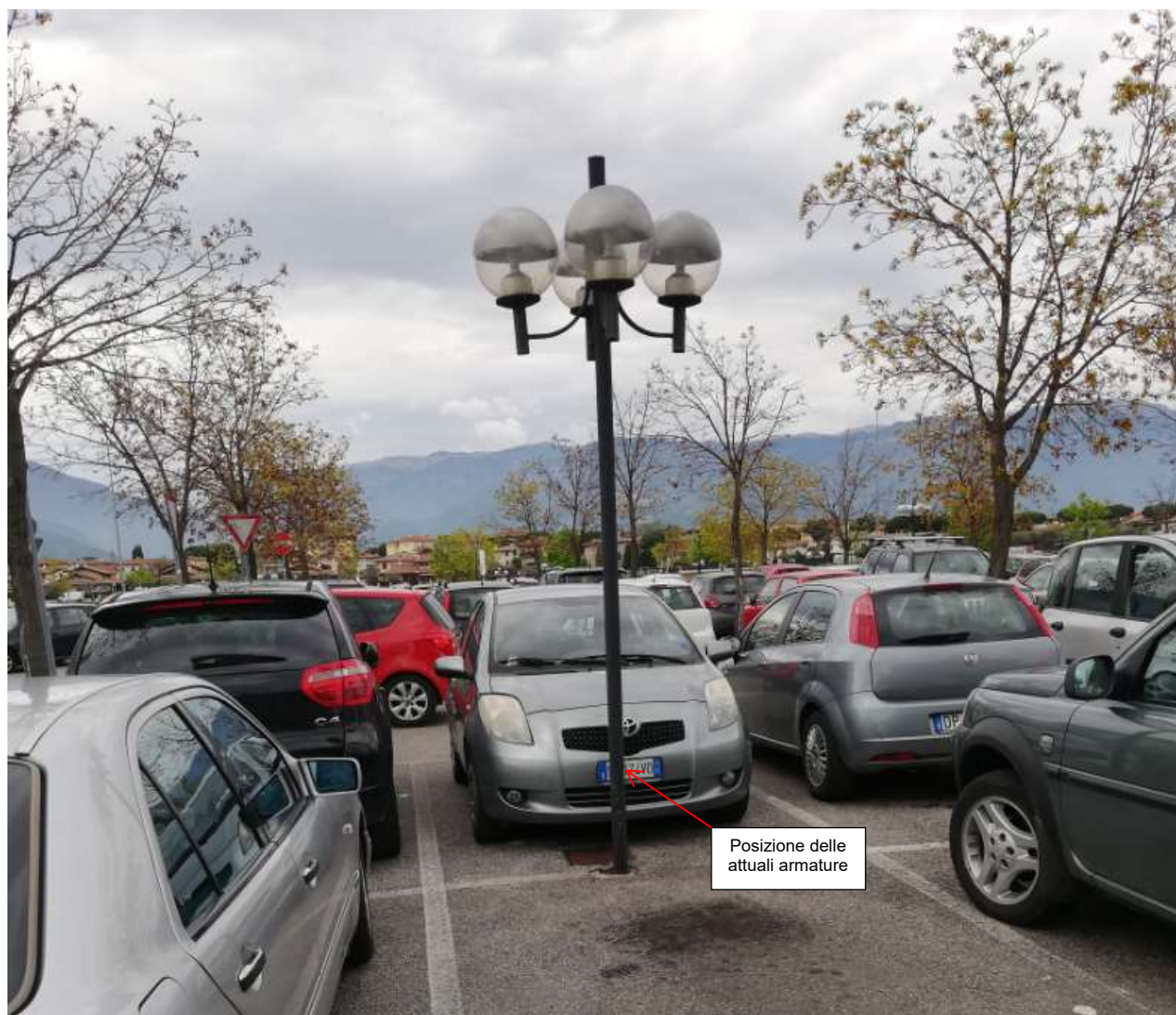
FOTO 1 - Armatura utilizzata. Si nota come l'armatura interferisca direttamente con i posti auto destinati alla sosta degli autoveicoli
