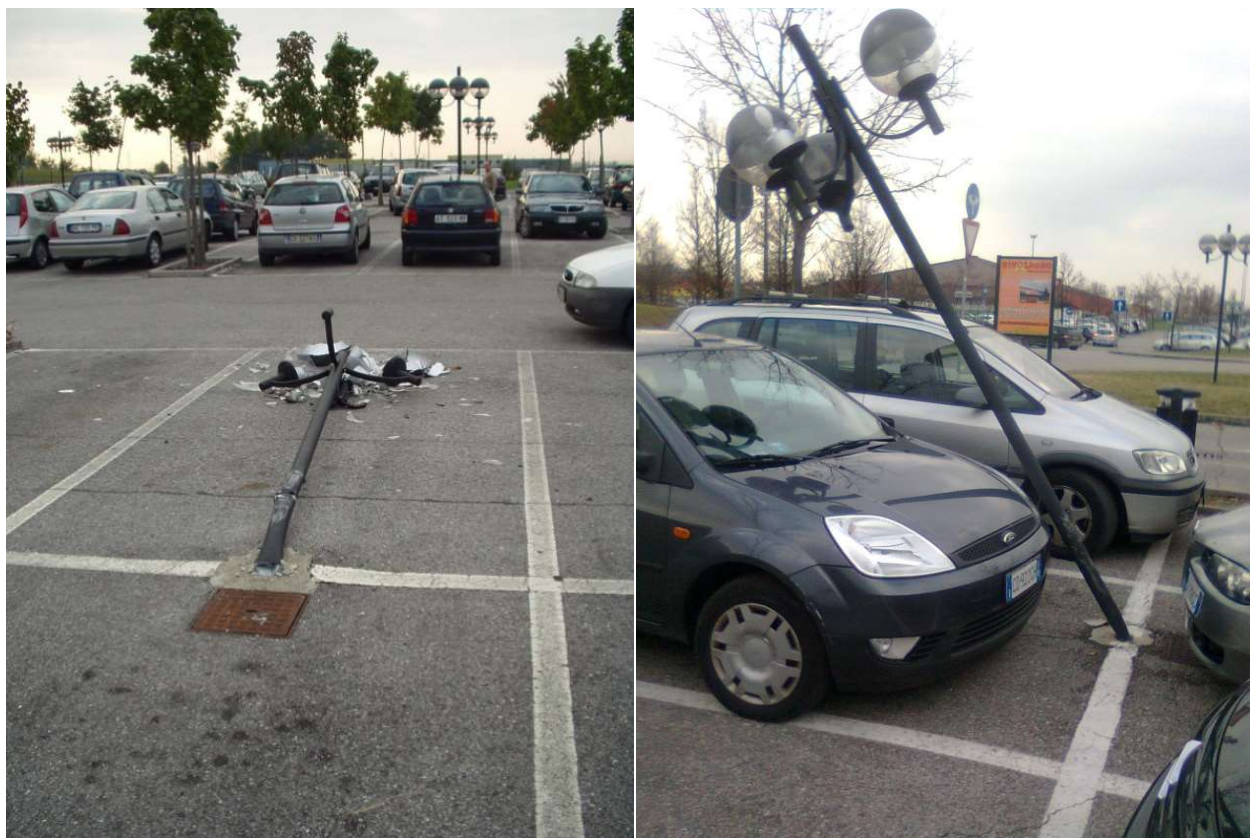
FOTO 2 - Armature abbattute e/o urtate.
