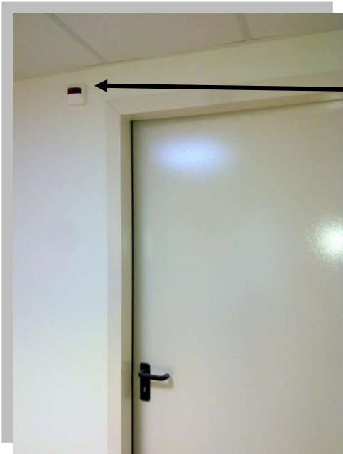
Pulsante manuale di allarme antincendio
