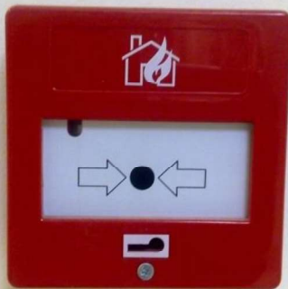
Pulsante manuale di allarme antincendio
