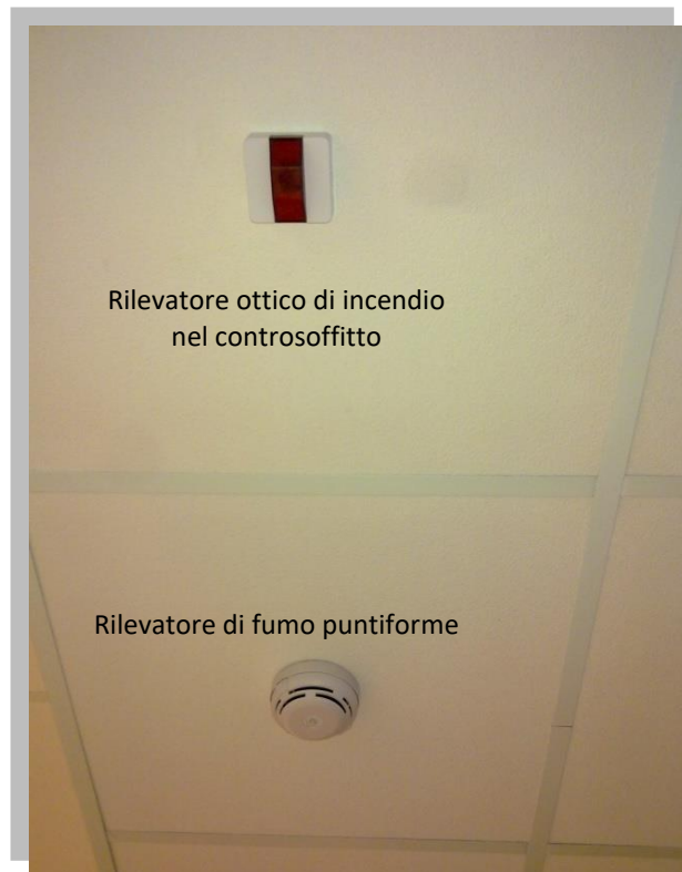
Rilevatore ottico di incendio lungo il corridoio, riferito a locale chiuso
